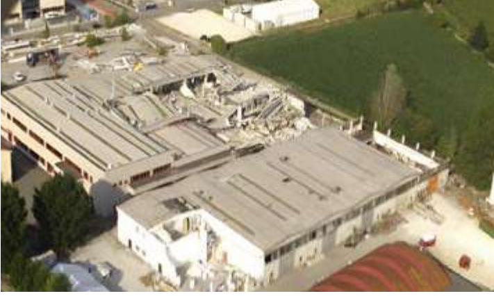
FOTOĞRAF 16. Deprem Etkisi İle Oluşan Cephe Çatı Sistemi ve Cephe Kaplaması Hasarları
