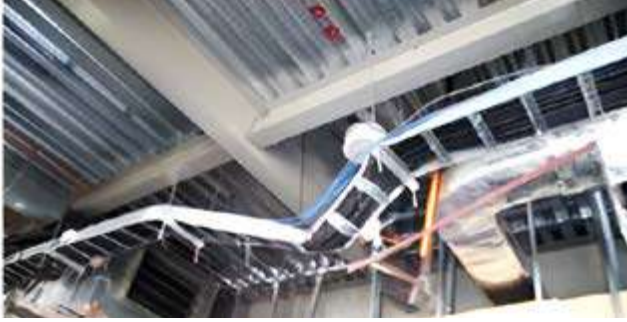
FOTOĞRAF 25. Deprem Etkisi Nedeniyle Oluşan Kablo Kanallarına İlişkin Hasarlar (Miranda, Mosqueda, Retamales, & Pekcan, 2012)
