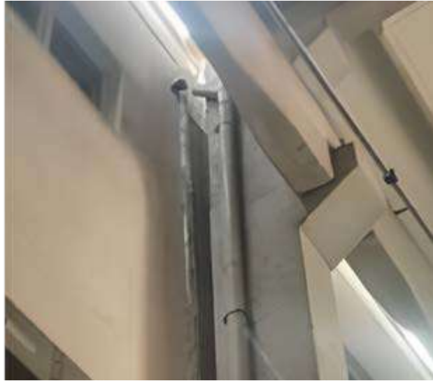
FOTOĞRAF 17. Deprem Etkileri Nedeniyle Yetersiz Deprem Derzinin Neden Olduğu Çarpışmaya Bağlı Gelişen Hasar Durumu (Yüksel vd., 2023)
