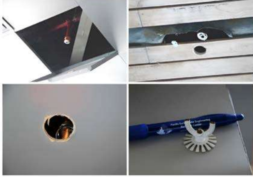
FOTOĞRAF 21. Deprem Etkisi Nedeniyle Oluşan Yangın Söndürme Boru Bağlantıları Hasarları (Miranda, Mosqueda, Retamales, & Pekcan, 2012).
