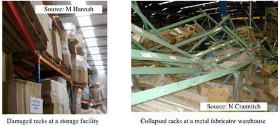
FOTOĞRAF 23. Deprem Etkisi Nedeniyle Oluşan Ağır Depo Raflarının Maruz Kaldığı Hasarlar (Dhakal, 2010)
