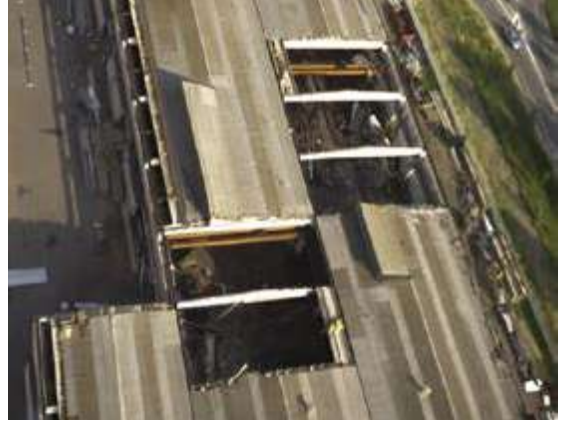
FOTOĞRAF 16. Deprem Etkisi İle Oluşan Cephe Çatı Sistemi ve Cephe Kaplaması Hasarları
