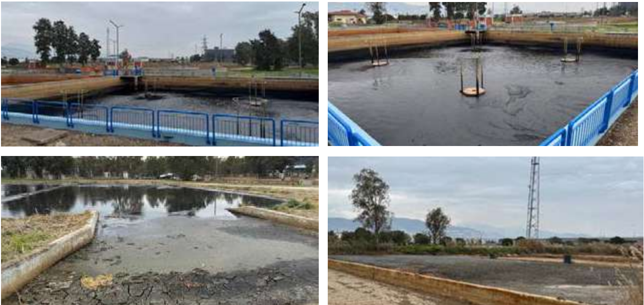
FOTOĞRAF 10. Atık Su Arıtma Tesisi ve Çamur Kurutma Yatakları
