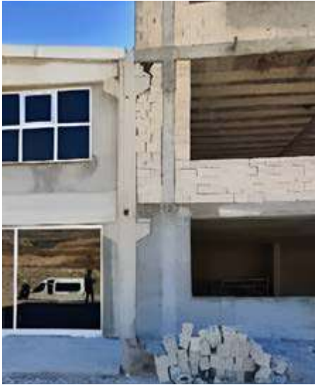
FOTOĞRAF 17. Deprem Etkileri Nedeniyle Yetersiz Deprem Derzinin Neden Olduğu Çarpışmaya Bağlı Gelişen Hasar Durumu (Yüksel vd., 2023)
