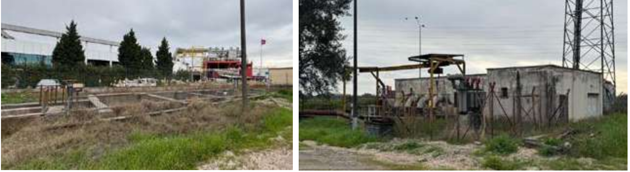
FOTOĞRAF 11. Kanalizasyon Şebekesi Atık Su Pompa İstasyonu
