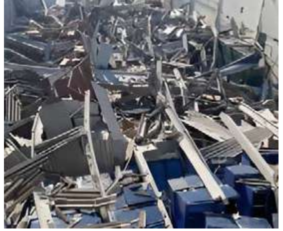
FOTOĞRAF 17. Deprem Etkileri Nedeniyle Yetersiz Deprem Derzinin Neden Olduğu Çarpışmaya Bağlı Gelişen Hasar Durumu (Yüksel vd., 2023)
