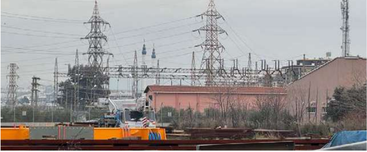
FOTOĞRAF 8. Bölgenin Kuzeyinde Bulunan Şalt Sahası
